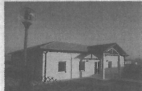
L'asilo nido di Quattordio, la prima scuola pubblica in Piemonte certificata CasaClima
